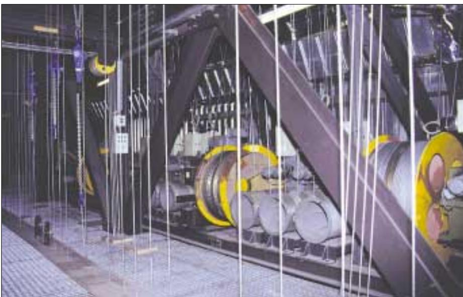
Auf dem Schnürboden in 26 m Höhe befinden sich u. a. die Antriebe und unzählige Umlenkrollen sowie ein regelrechter Wald aus Seilen.
